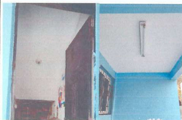
Foto 3: Mejoramiento del sistema eléctrico.
